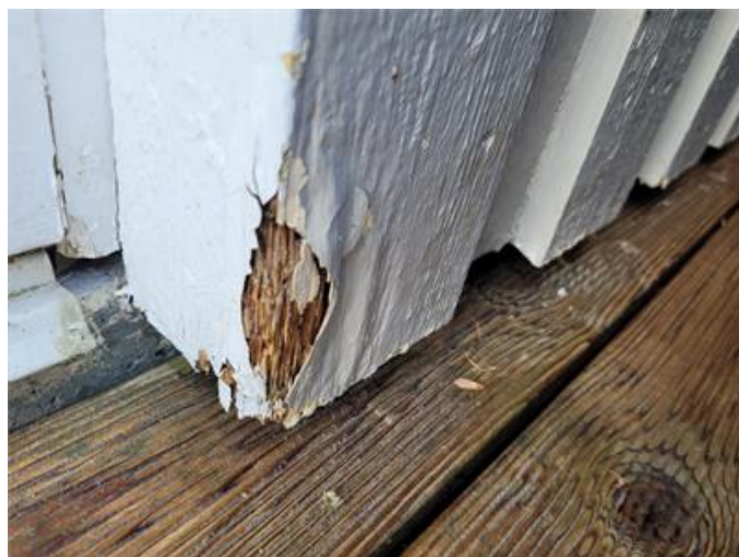
Rötskadad fasadpanel
