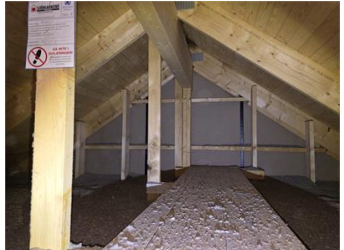
Nockvind: Översiktsbild mot väst.
