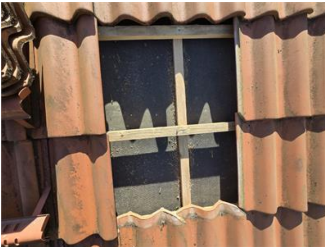
Tak: Stickprovskontroll under pannor.
