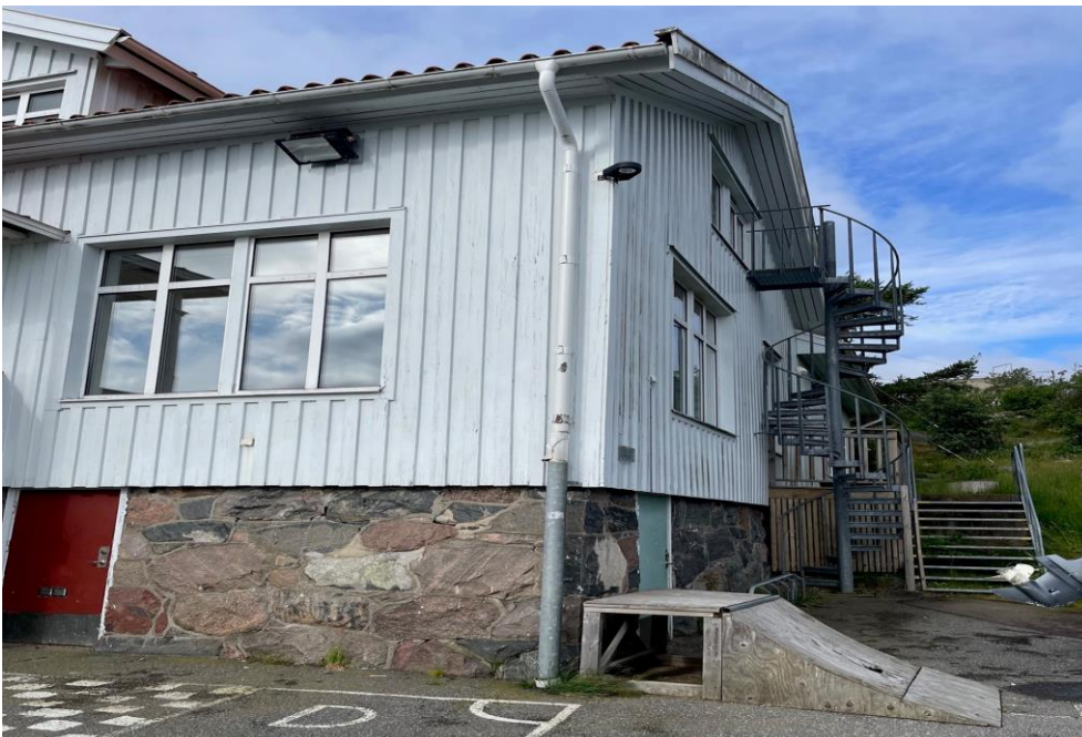
Figur 2. Befintligt stuprör vid skolans nordvästra hörn.
