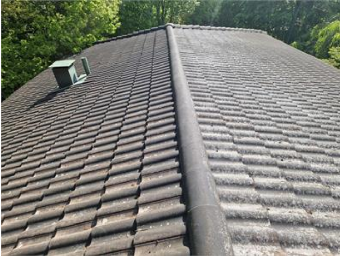
Vy på yttertak
