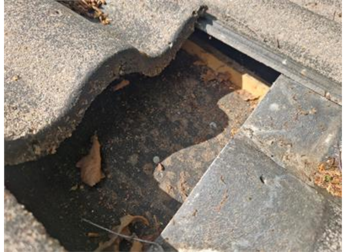
Vy på underlagstak
