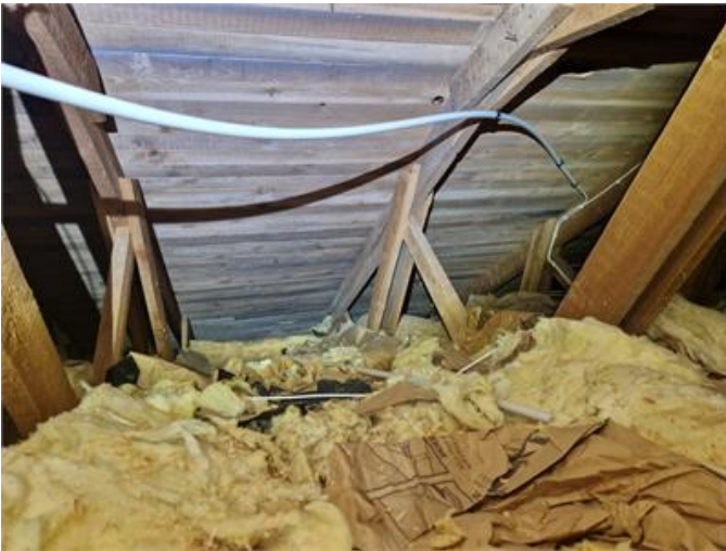
Vy på vindsutrymmet
