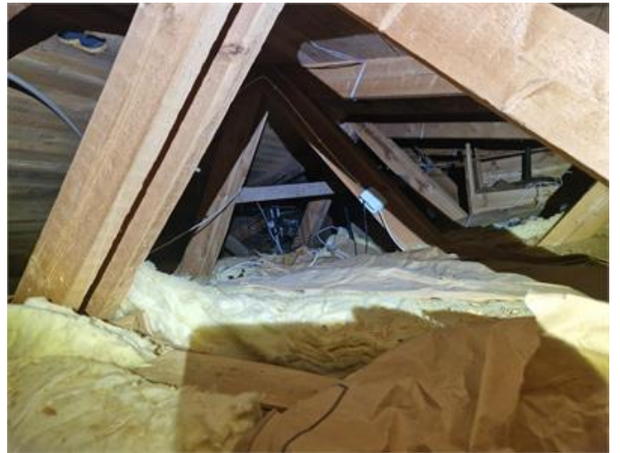
Vy på vindsutrymmet
