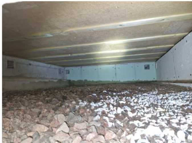
Krypgrund, översiktsbild östra vinkel utbyggnaden.
