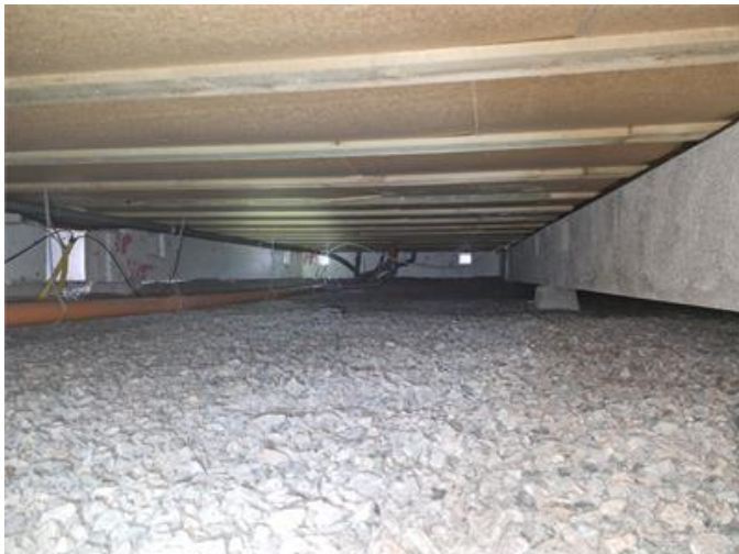
Krypgrund, översiktsbild västra delen.
