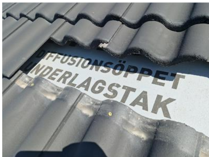
Tak, underlagstak av takduk på ursprunglig del.
