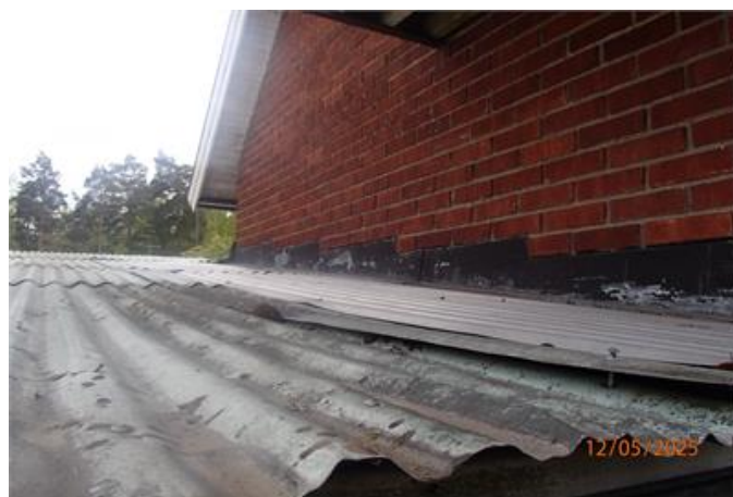
Garage tak (takbyte rekommenderas)
