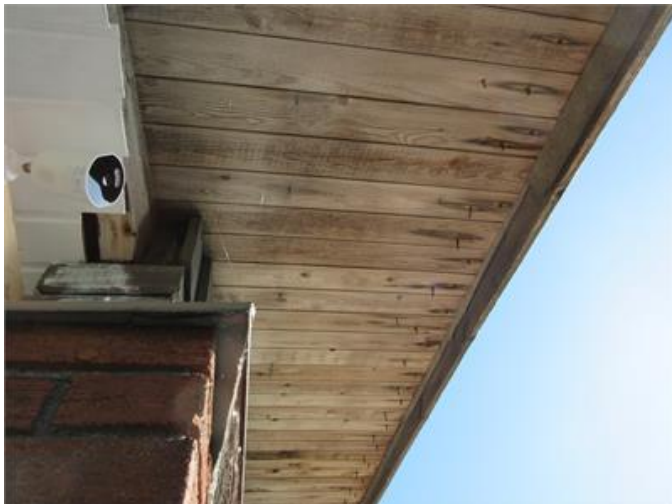
Taksims/fasadsida med målning/underhållsbehov
