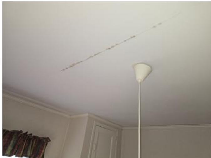
Missfärgning i innertak, sovrum 1.
