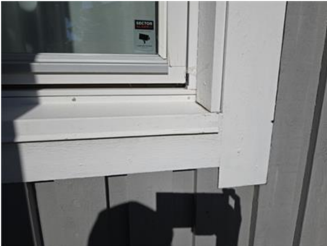
Exempel på fönsterbleck.
