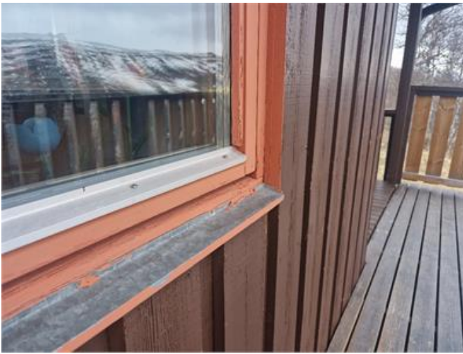
Fönster och fasad
