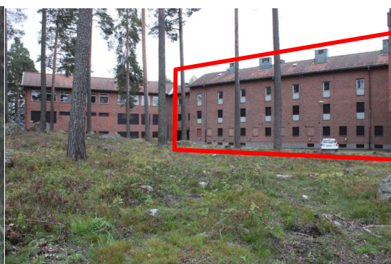
Byggnad 2, fasad mot nordost.
