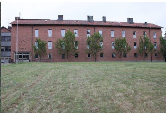
Byggnad 1, fasad mot nordväst.
