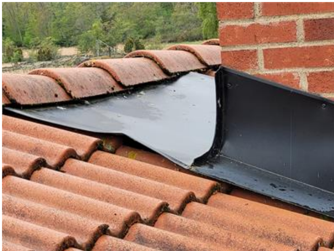
Plåtbeslag invid skorsten
