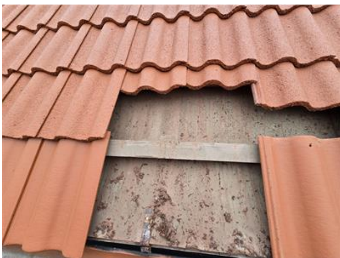
Tak: Stickprovskontroll under pannor.
