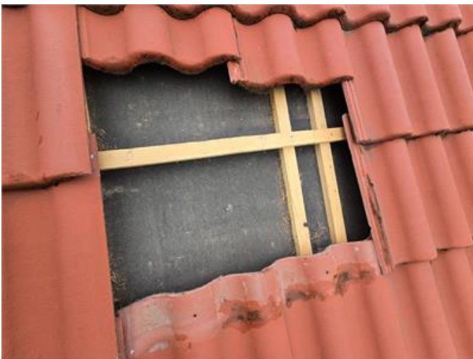
Tak: Stickprovskontroll under pannor.
