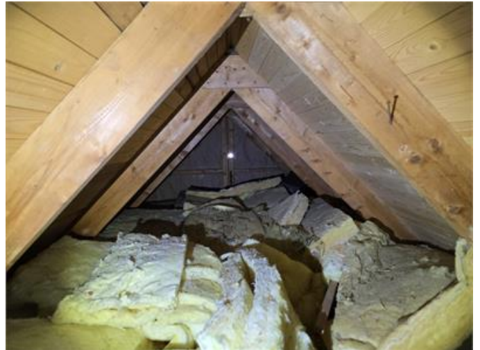
Nockvind: Översiktsbild, bristfälligt utlagd isolering.
