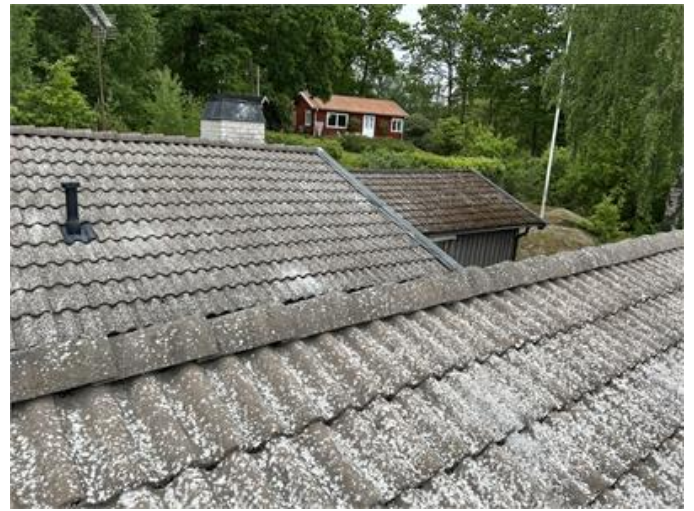
Tak: Översiktsbild med ihopbyggda sadeltak.
