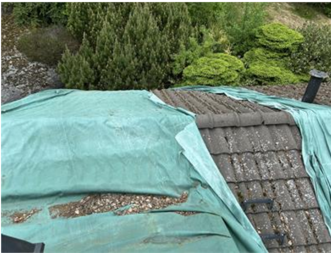
Tak: Presenning på delar av taket.
