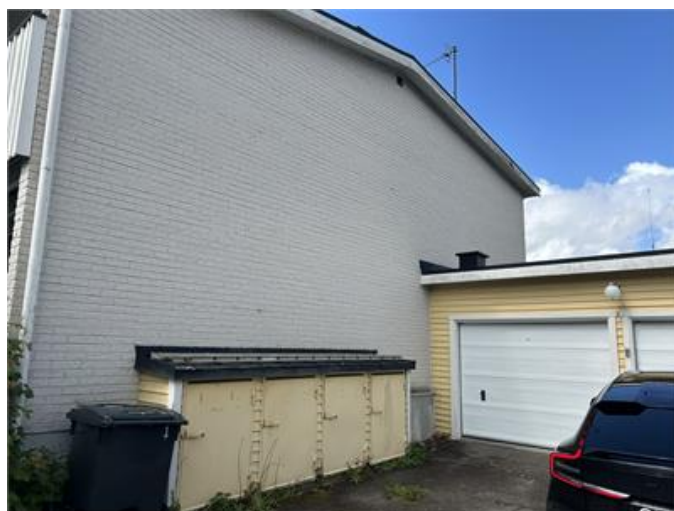
Fasad: Delvis vidbyggt garage.
