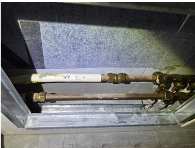
Dusch/Bad/Wc: Vattenkopplingar i låda bakom badkar.
