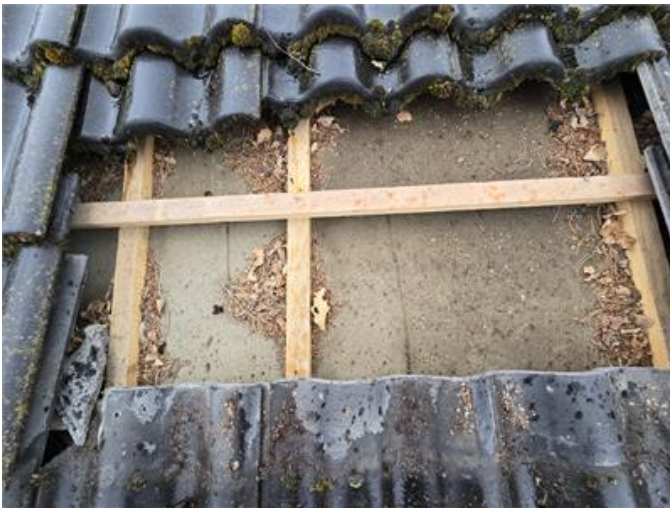
Tak: Stickprovskontroll under pannor, mycket löv/frömjöl.
