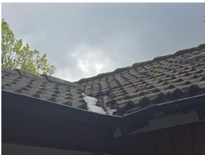
Exempelbild, brister kring vinkelränna tak.
