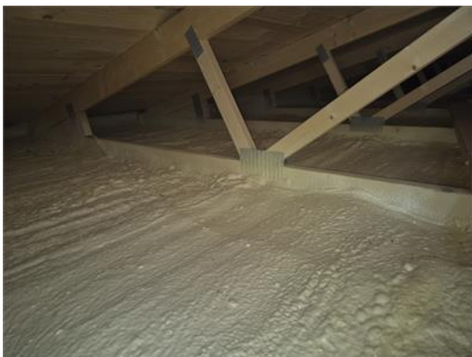
Bild från vindsbjälklag isolerat med fogsium.
