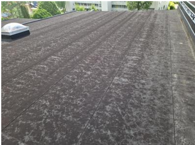
Vy på yttertak
