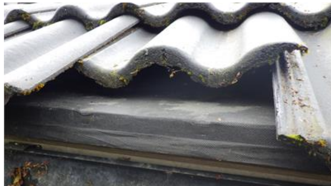
Vy av tak där takpannorna ligger mot underlagsduken
