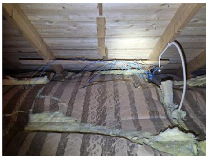
Nockvind, löst hängde eltrådar till takspotar Entre.
