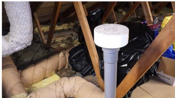
Avloppets luftarrör leds inte ut genom yttertaket utan avslutas på vinden med en vakuumventil.
