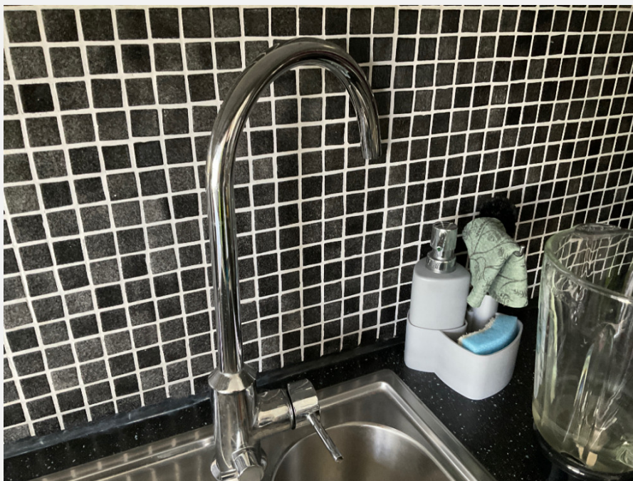
E2 Övrigt - Bruksrester, fogfilm, silikonrester förekommer allmänt
