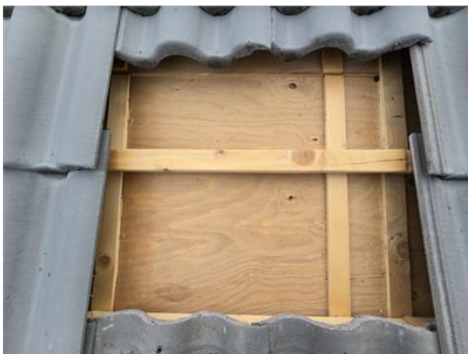
Tak: Stickprovskontroll under pannor.
