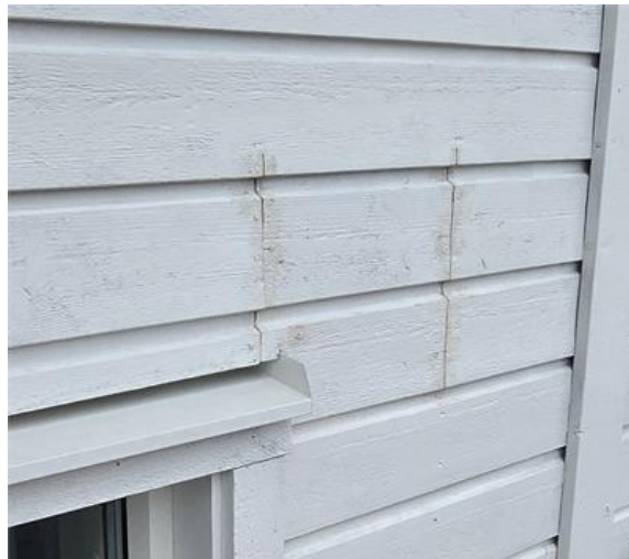
Fasad: Lagning i fasad.
