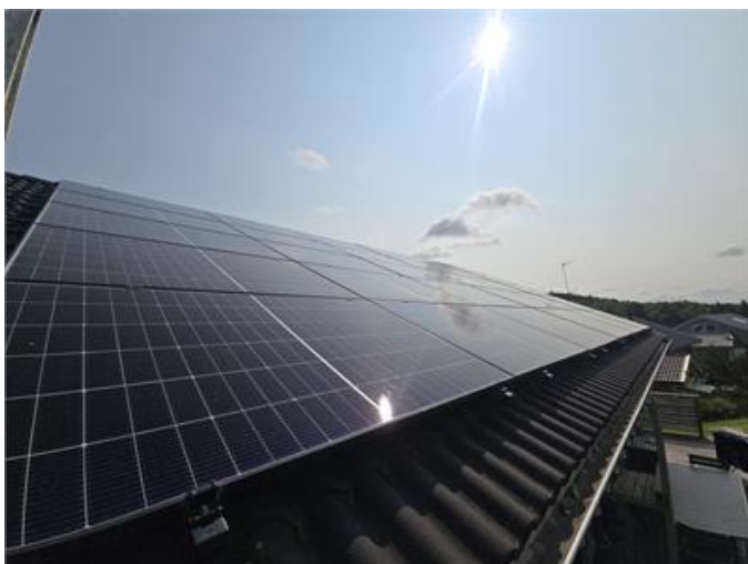
Översiktsbild, yttertak med solcellspaneler.
