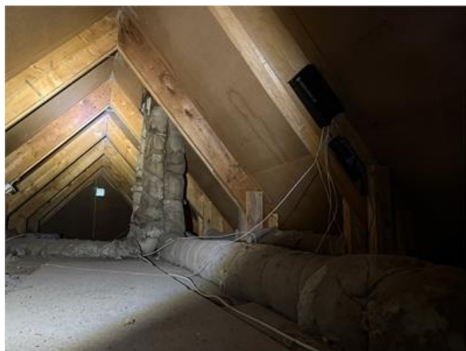
Missfärgning underlagstak.
