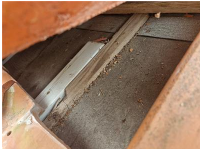
Äldre tak papp under tegelpannor.
