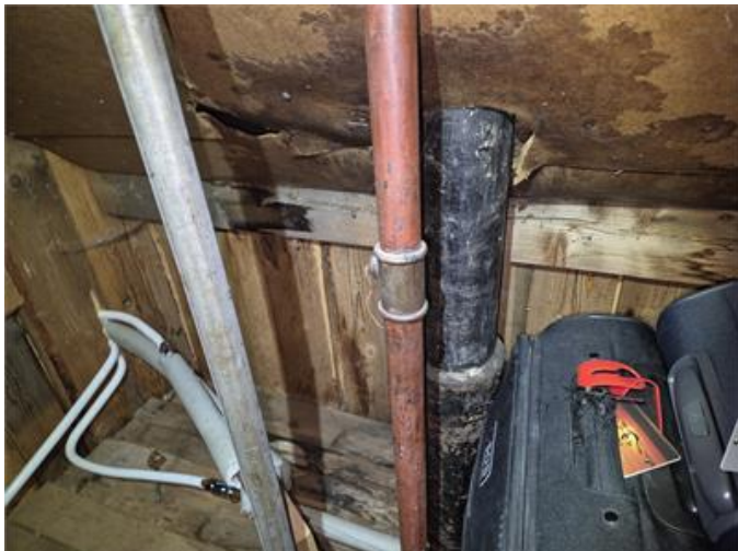
Äldre skada vid ena sidovinden.
