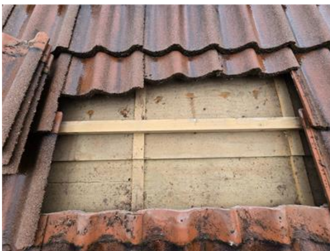
Tak: Stickprovskontroll under pannor.
