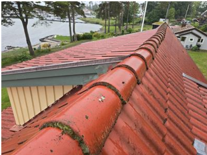
Nockpannor med justeringsbehov och exempel på låglutande del av tak.
