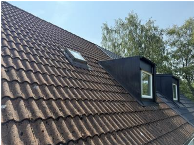
Översiktsbild på yttertak
