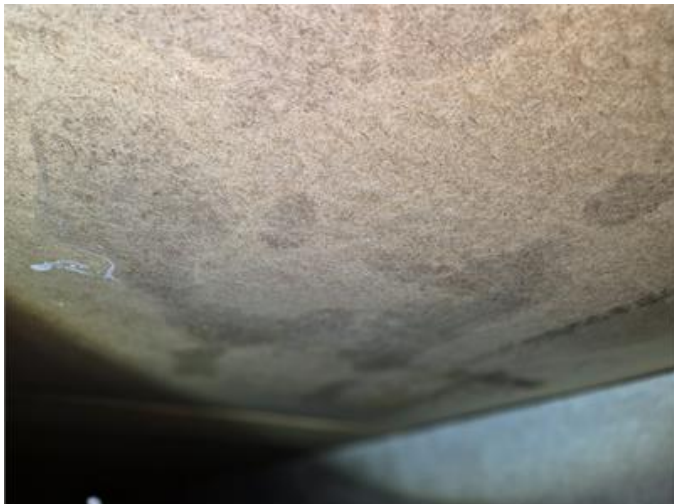
Bild från krypgrunden.
