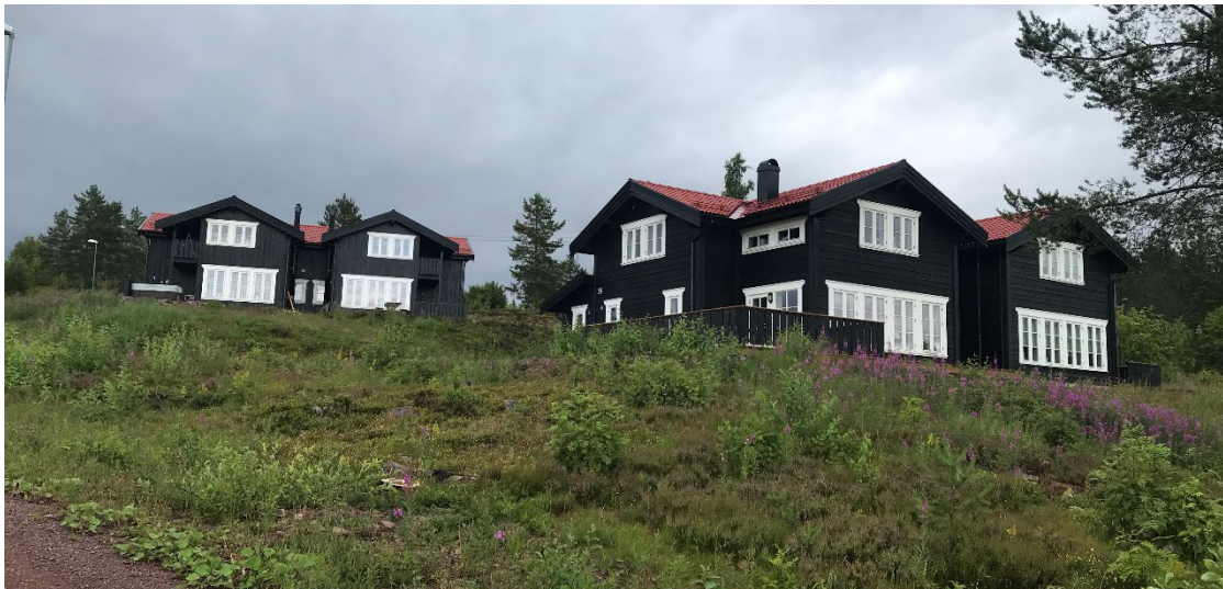
Relativt nybyggda parhus i norra Toppbyn.
