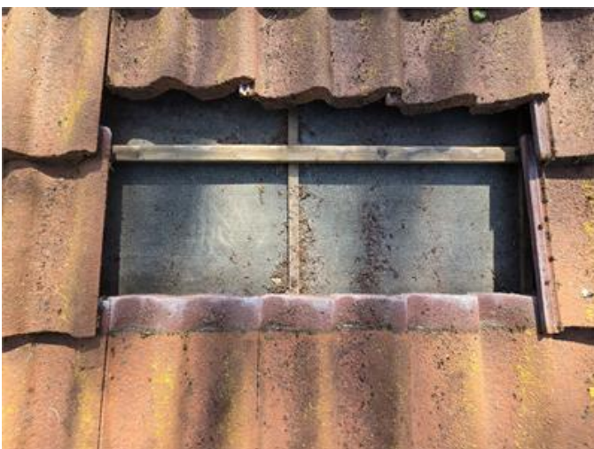
Tak: Stickprovskontroll under pannor, äldre underlagspapp samt löv/barr/frömjöl.
