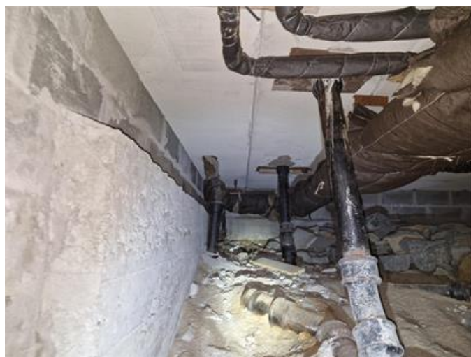
Bergsrum/Krypgrund, äldre avloppsrör av gjutjärn.
