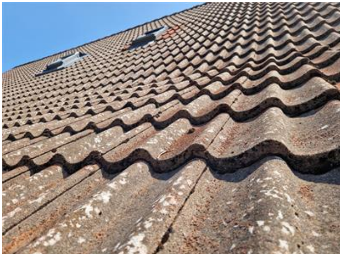
Vy på yttertak
