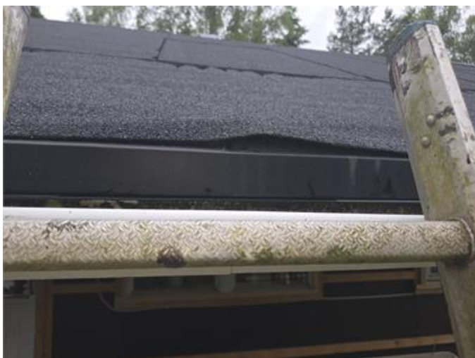
Exempel på otätheter vid fotplåt.
