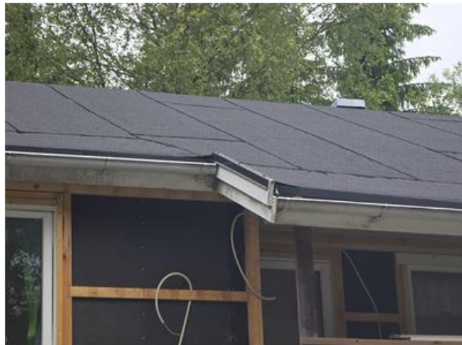
Exempel på otätheter vid fotplåt.
