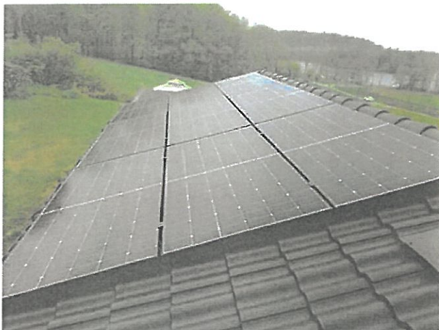
Delar av takpannor ej besiktningsbara pga solcellspaneler.
