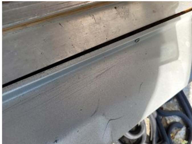
Tröskelplåt tätar ej korrekt
