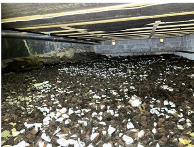
Krypgrund östdel: Översiktsbild
