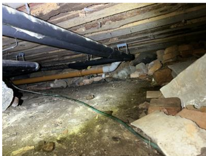
Krypgrund norrdel: Översiktsbild
