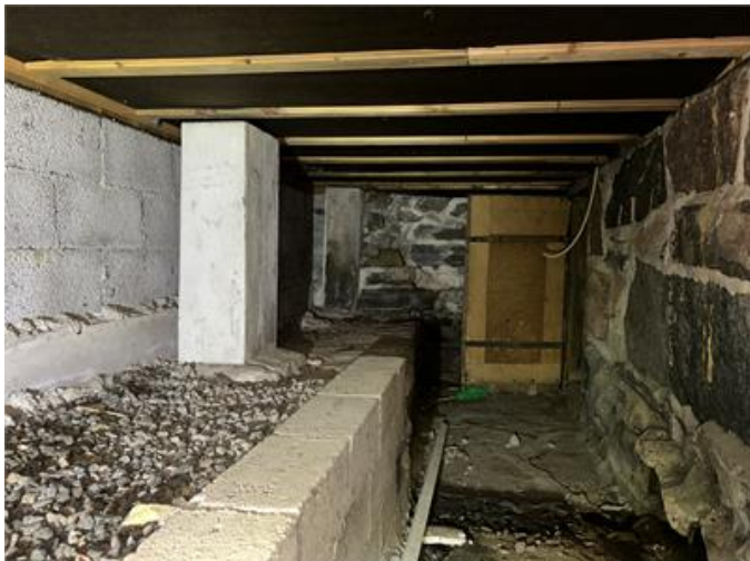
Krypgrund Västdel: Översiktsbild.
