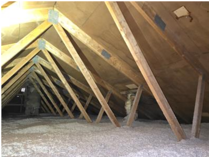
Överblick del av vind.
