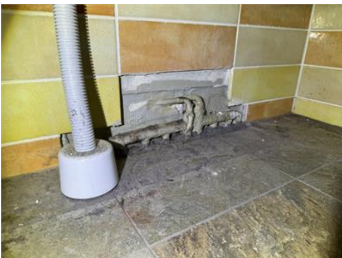
Rör genomföringar i golv i badrummet under tvättställ.
