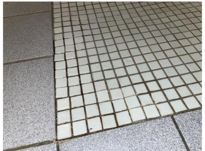
Lös mosaik och bomljud under klinkers på golv förekommer dusch/WC.
