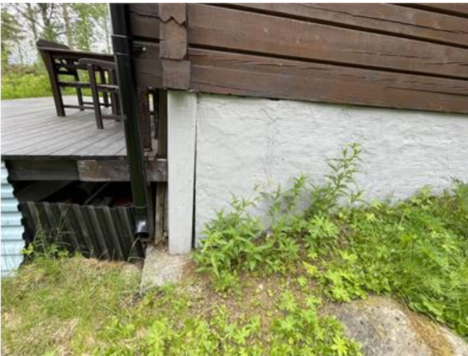
Otättheter och sprickor förekommer på sockel.
