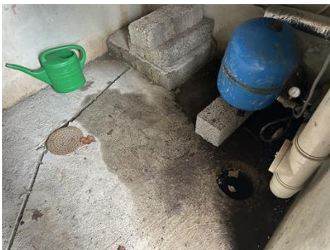
Källare: Översiktbild med uppsamlingsghål i golv för enklare tömning av vatten.
