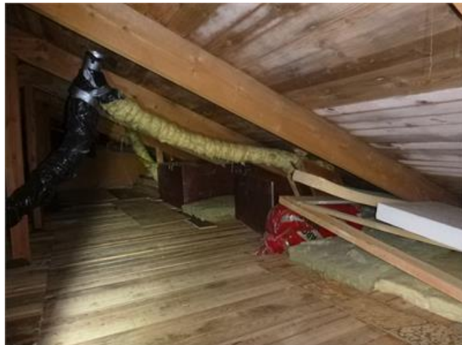
Bilden visar vy av vind.
