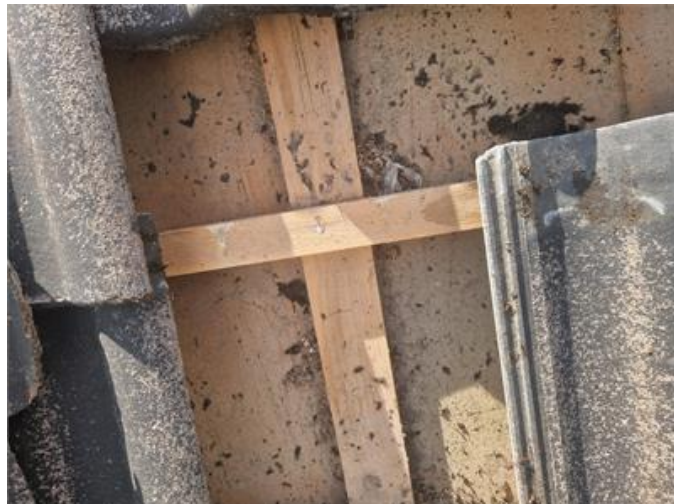
Vy på underlagstak
