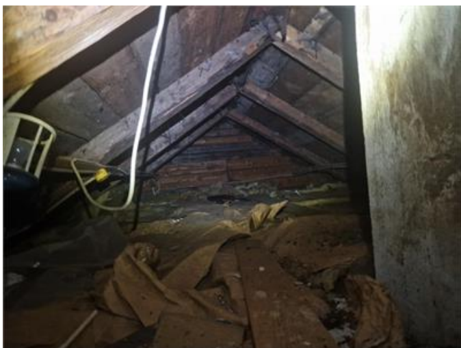
Vy på vindsutrymmet
