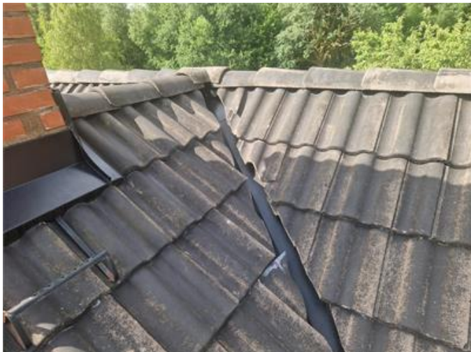
Vy på yttertak
