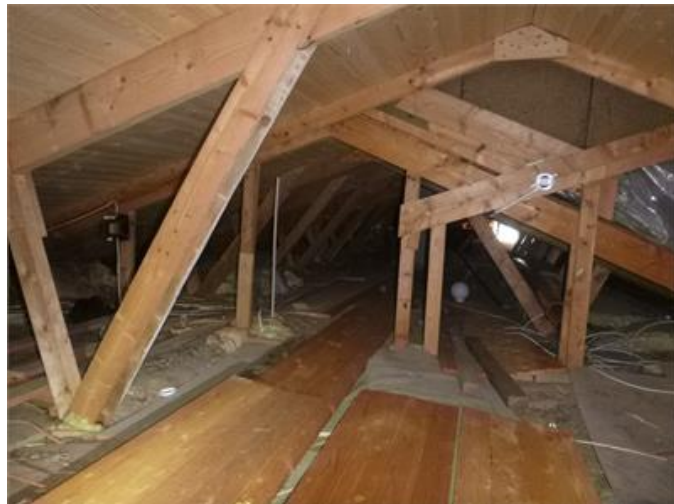
Bilden visar vy av vind.
