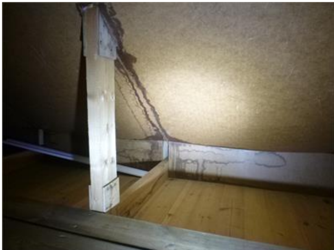
Bilden visar exempel på missfärgningar (sidovind).
